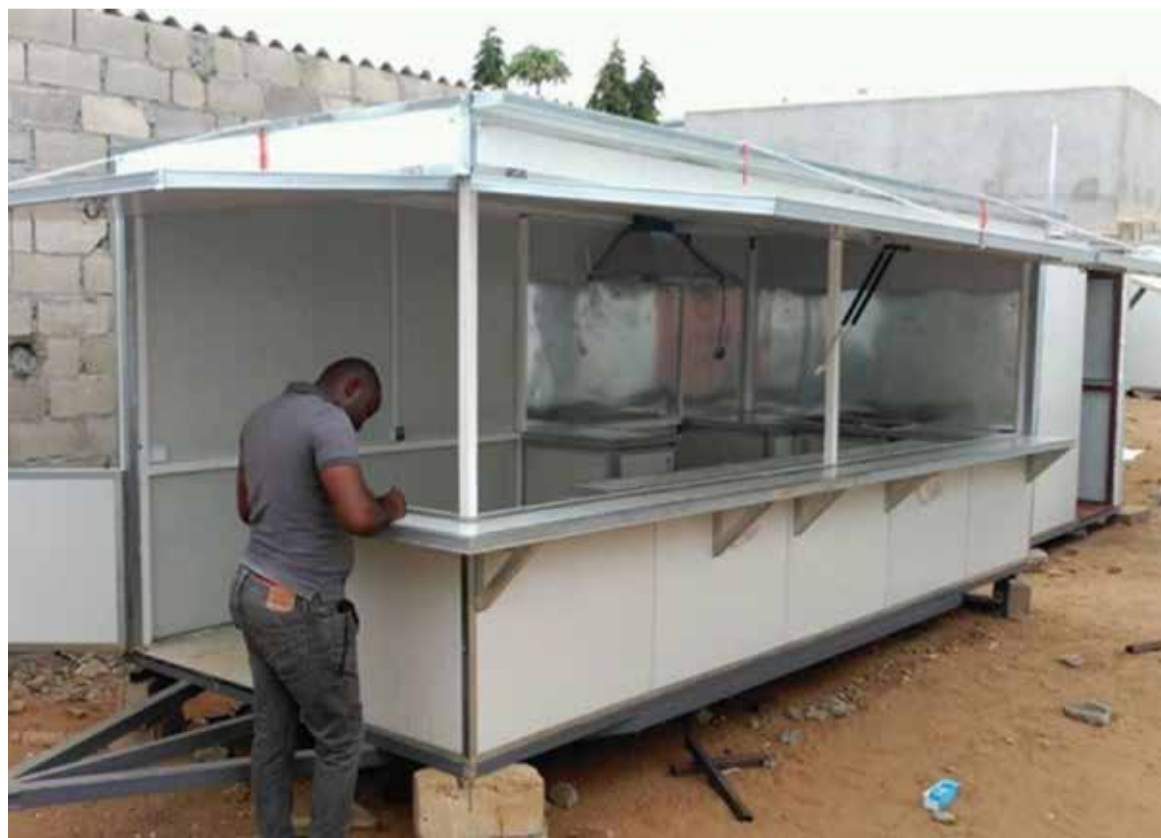
Essa é uma das estruturas que está a ser fabricada na oficina do empreendedor no Benfica em Luanda
